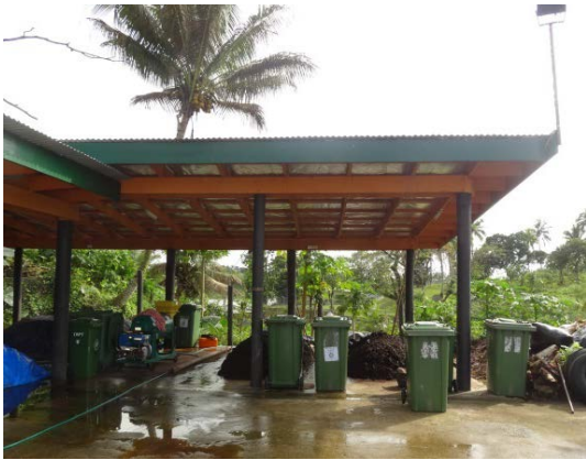
草の根無償資金協力で整備された スバ市コンポストセンター作業場 (フィジー)
