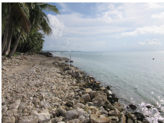
沿岸災害対応のための礫養浜 パイロットプロジェクト事業サイト (ツバル)
