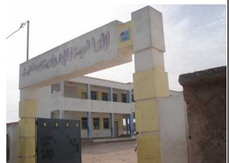
エルジャディーダ県に建設された中学校(撮影:評価チーム)
