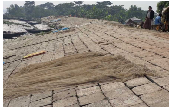
現在の堤防の様子
