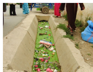
図 1-18 モロッコ・ケニトラ市郊外の排水溝（写真）
