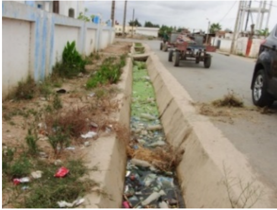
地方都市（ケニトラ）の市街地の側溝
