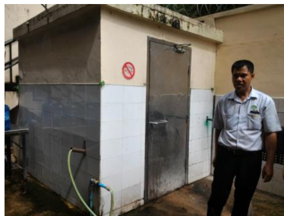
同ホテルのゴミ保管庫
