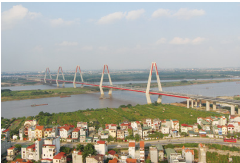
2015年に開通したベトナムのニャットン橋
