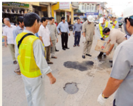
道路の損傷個所に、道路補修材「エクセル」を使用する様子（写真：（株）愛亀）
