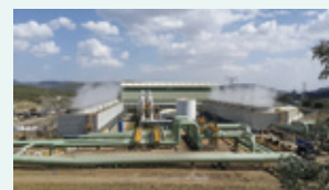
オルカリア地熱発電所 (写真: JICA)
