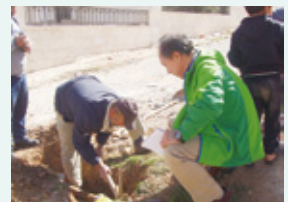
ヤムルーク水道公社(YWC)職員による配水管の漏水調査
