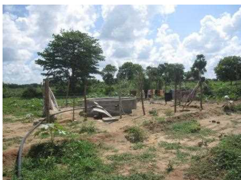
2013年10月 完成した農業用井戸
