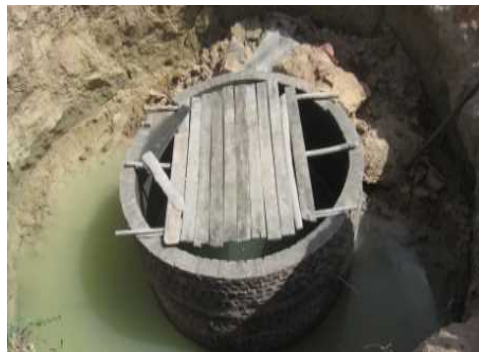
2013年8月 井戸建設石作業
