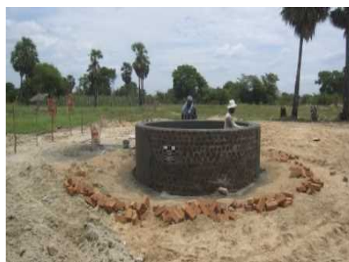
2013年9月 井戸建設石工作業
