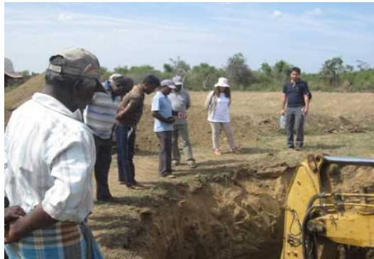
2013年7月 本部出張者の掘削現場モニタリング
