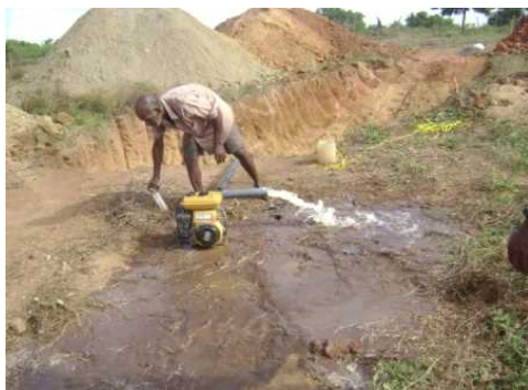
2013年7月 井戸建設中に掘削した穴に貯まった水の排水作業
