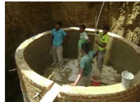
2013年8月 井戸建設石作業
