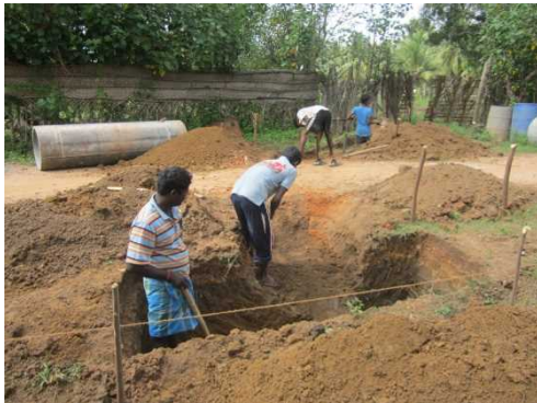
2014年1月 カルバート建設作業(プドゥクリルプ郡ビシュワマドゥウエスト地区)
