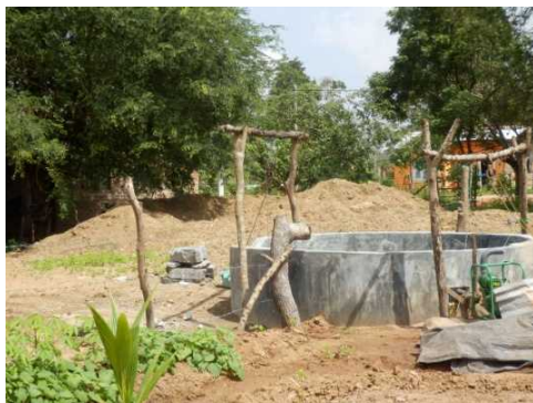
2014年1月 井戸周りに設置したフェンス (サンパットゥヌアラ郡)
