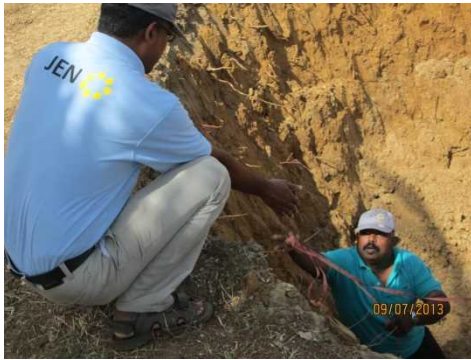
2013年7月 掘削深度の計測 (ブドゥクリルプ郡ビシュワマドゥウエスト地区)
