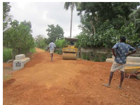
2014年1月 カルバート建設の整地作業(プドゥクリルプ郡ビシュワマドゥウエスト地区)
