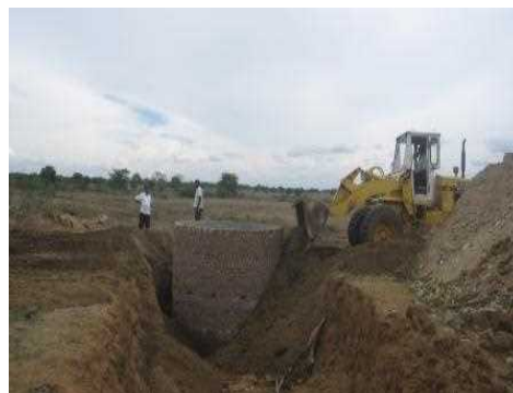
2013年9月 井戸建設掘削作業
