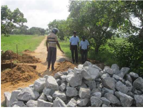
2014年1月 建設作業中のカルバート (プドゥクリルプ郡ビシュワマドゥウエスト地区)
