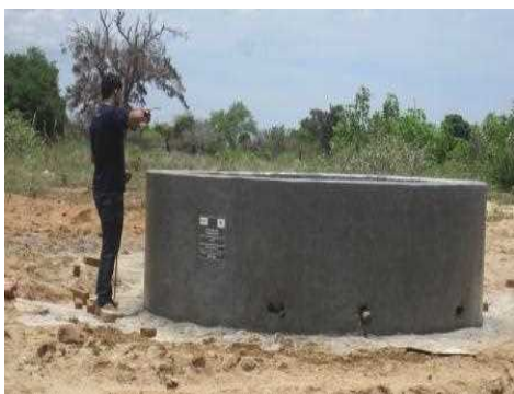
2013年9月 井戸建設最終工程作業
