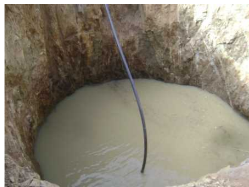
2013年7月 井戸建設 水量調査
