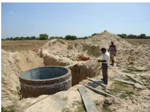
2013年8月 県庁NGOコーディネータによる井戸 建設作業確認
