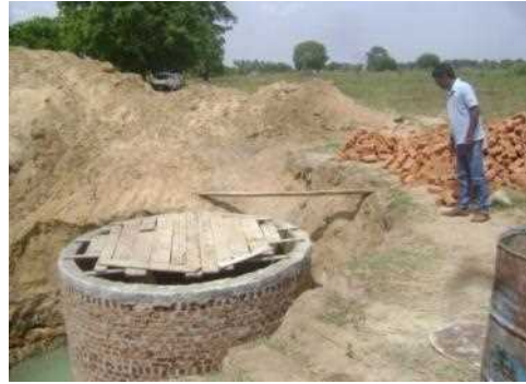
2013年8月 井戸建設石作業
