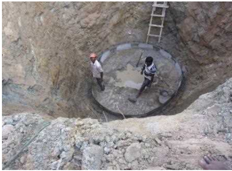
2013年7月 井戸建設石作業
