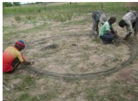
2013年7月 コンクリート基礎の建設準備
