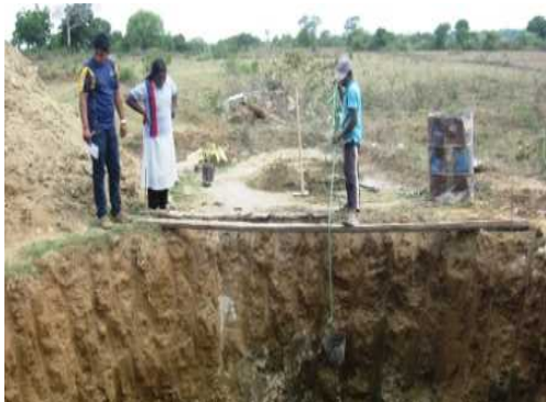
2013年8月 井戸建設掘削作業
