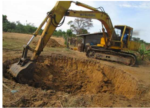
2013年7月 井戸建設の掘削作業 (ブドゥクリルプ郡ビシュワマドゥウエスト地区)
