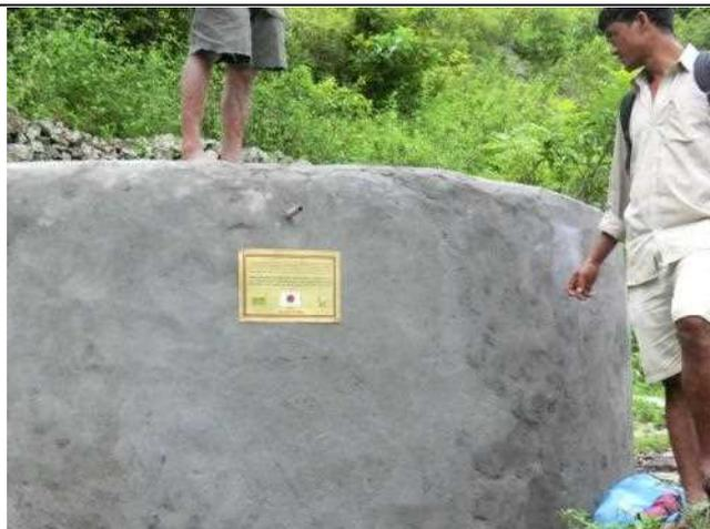
中地エリア(タマンコミュニティ)に建設した自然流下式小規模灌漑、合計 150 世帯が裨益する。灌漑は飲料水の供給も兼ねており、貯水タンクの建設資材である石の切り出しや砂の運搬などの作業には女性も積極的に参加して建設を完了した。
