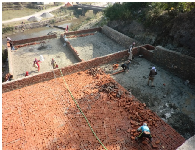
人工湿地にレンガを敷き詰める様子
