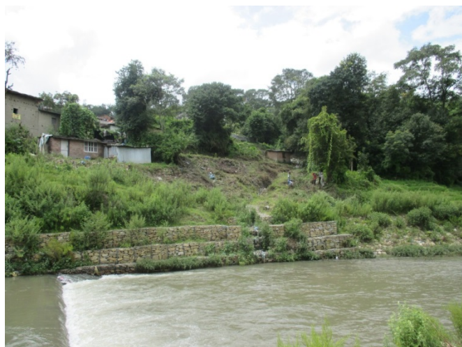
ゴカルナ・デシェ村 施設建設前
