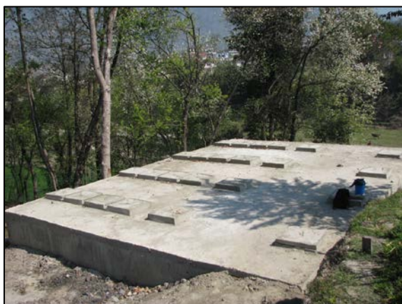
セトラ（右側）と ABR（左側）完成
