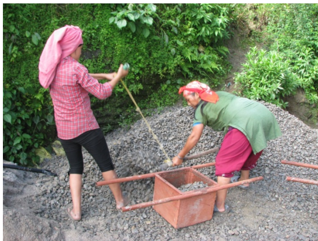
建設作業には多くのデシェ村女性も従事
