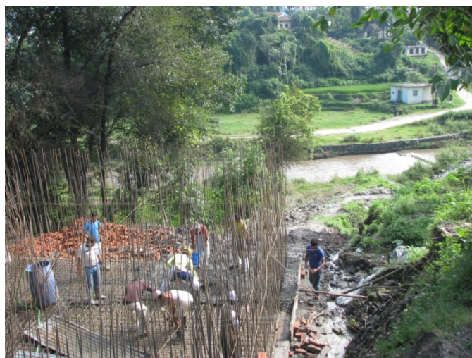
建設開始1ヶ月半後、セトラー & ABR
