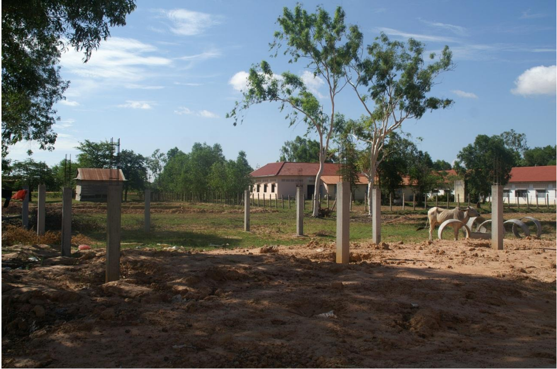
CLC # 2 多目的スペース 建設の様子 （※ 5 月下旬撮影）
