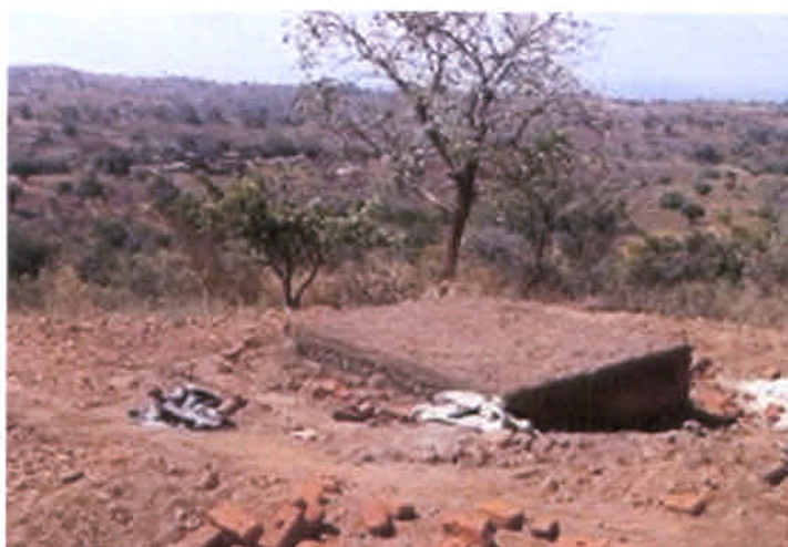
待機所と同様に、地下外壁を作成後、床スラブを完 成させる。(ザンドウ)
