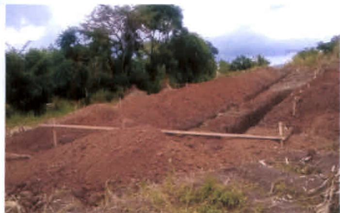
掘削工事の様子。(ムンディンダ)
