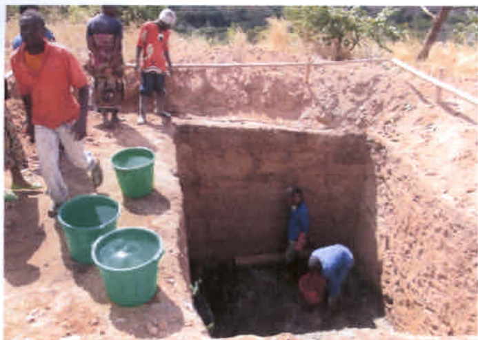
トイレ予定地の掘削作業を終え、水をまき土地を ならす。(ザンドウ)
