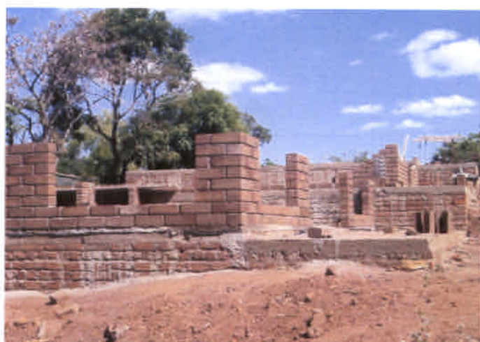
エンジニアによる強度確認が行われたレンガを使用して外壁工事を行う。(ザンドゥ)
