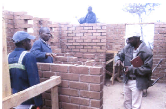
シャワー室となる部分を入念に確認するプロジェクトエンジニアと建設業者。(ザンドゥ)
