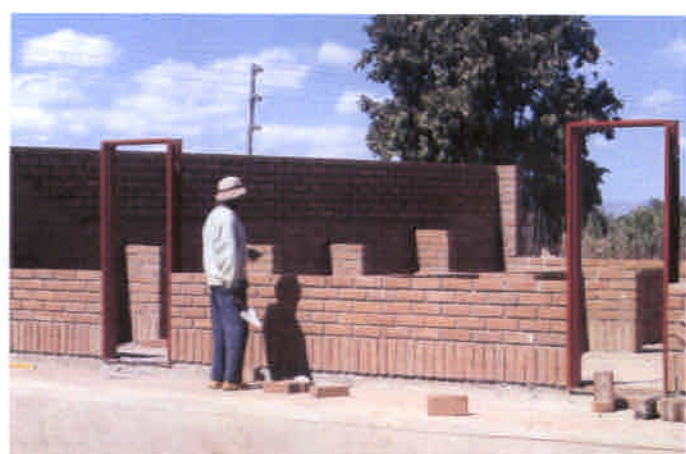
外壁がおよそ1メートルの高さまで来たら、ドア枠を取り付ける。(クーイ)
