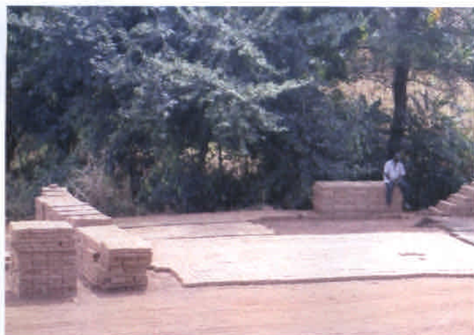
基礎工事と並行して外壁部分に用いるレンガ (Stabilized Soil Bricks) を作成する。(ムンディンダ)
