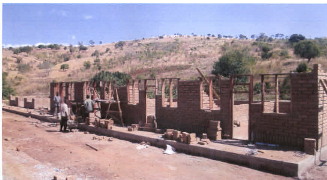
外壁がおよそ1メートルの高さまで来たら、ドア枠を取り付ける。(クーイ)
