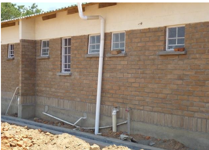
下水管の取り付け完了 2013 年 11 月
