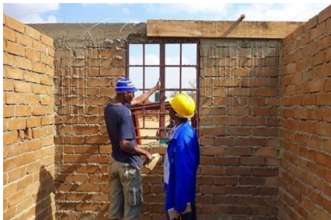
外壁の確認・検査を行い、建設業者への改善方法について詳細に指示・やり直しを行った 2013 年 8 月
