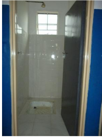
手洗い場とシャワー室の完成 2014 年 1 月
