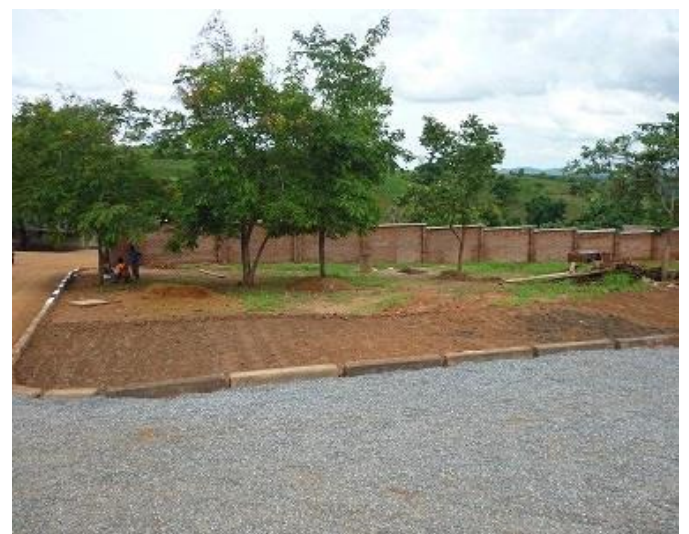
ヘルスセンター全体を囲う外壁の完成 2014 年 1 月
