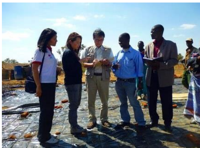
WVJ プロジェクト統括の訪問で進捗や工期、および、Slab 工事完了の確認 2013 年 7 月
