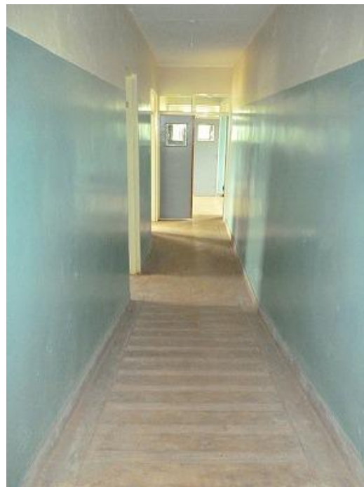
産科棟内：塗装、スロープ付き廊下、ドアが完成 2014 年 1 月
