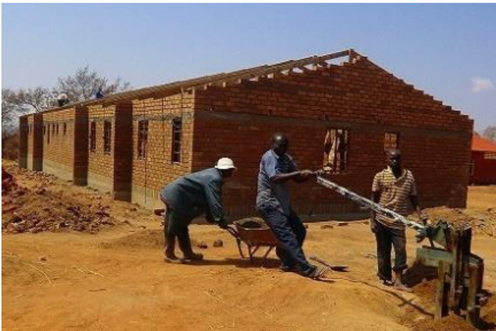
セメント、土、(砂) を使ってレンガ (Stabilized Soil Blocks) を作成 2013 年 9 月
