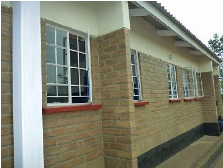
外壁の塗装完了 2014 年 1 月
