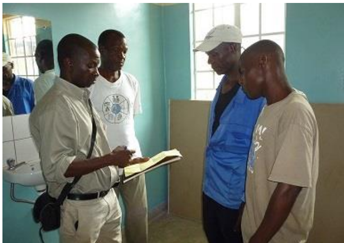
プロジェクト・エンジニアが建設業者と内装の最終確認 2014 年 1 月
