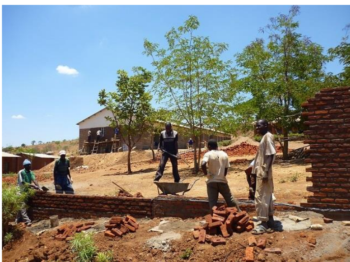
Mndinda ヘルスセンター全体を囲う外壁の建設 2013 年 12 月
