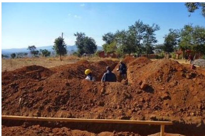
基礎工事(掘削作業)のモニタリング時 基礎工事が適切に行われているかを確認しているエンジニアと建設業者関係者 2013 年 7 月
