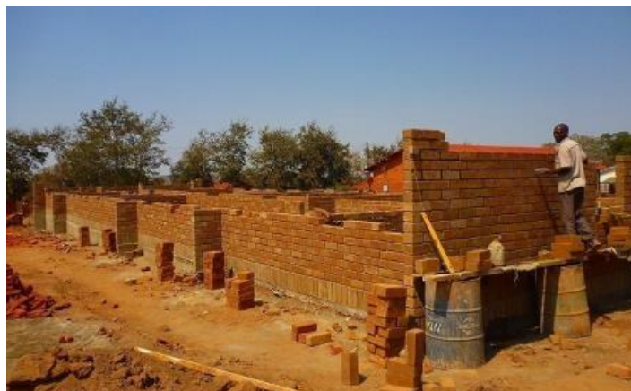
外壁工事進捗 使用しているレンガ質の検査、コンクリートの配合の検査等を常時実施 2013 年 8 月
