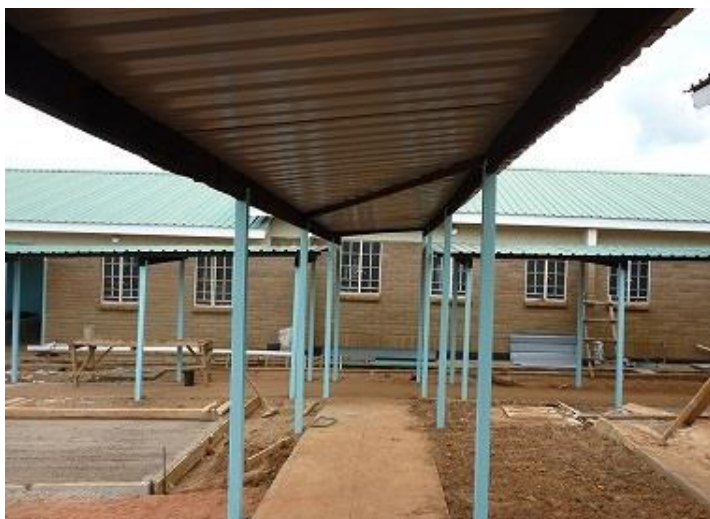
HTC および外来棟から産科棟へ通じる渡り廊下の完成 2014 年 1 月
