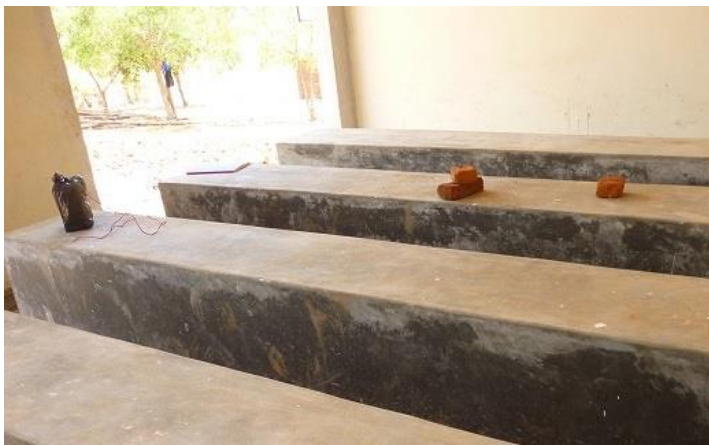
産科棟入口に設置された患者待合所 2013 年 11 月
