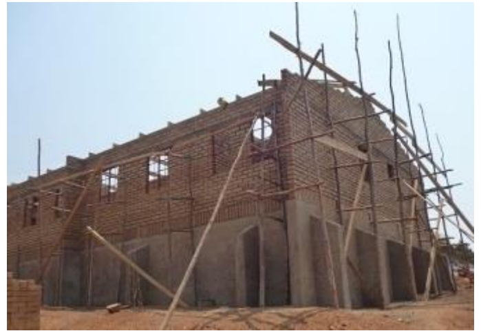
産科棟全景 2013 年 9 月
