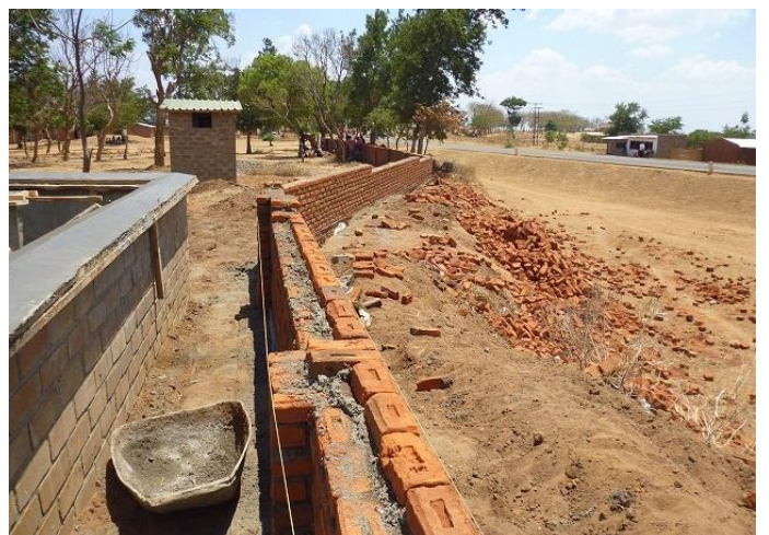
Khuwi ヘルスセンター全体を囲う外壁の建設 2013 年 12 月
