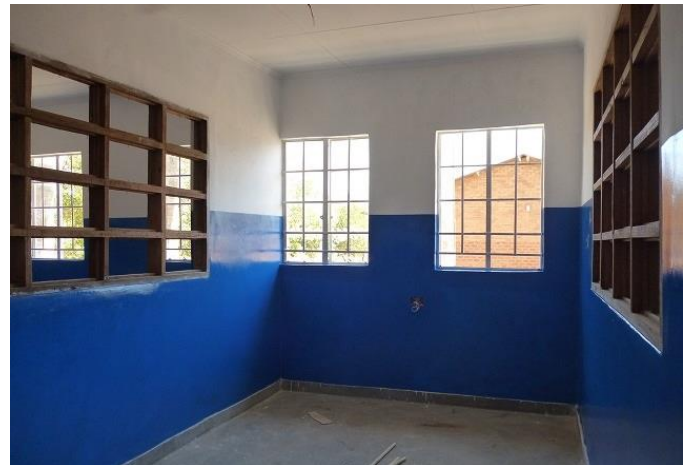
医療スタッフ事務所 両壁に窓枠が取り付けられ、隣にある産前産後用の病室を見渡せるようにしてある 2013 年 10 月
