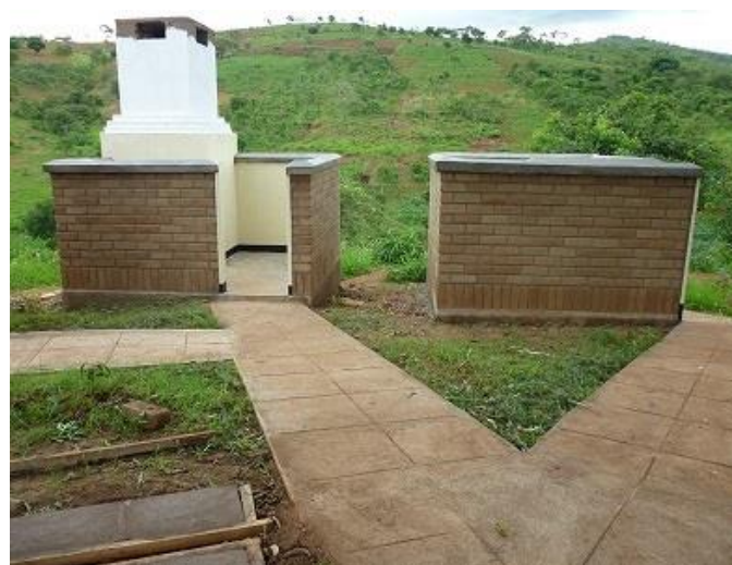
焼却炉の設置完了 2014 年 1 月
