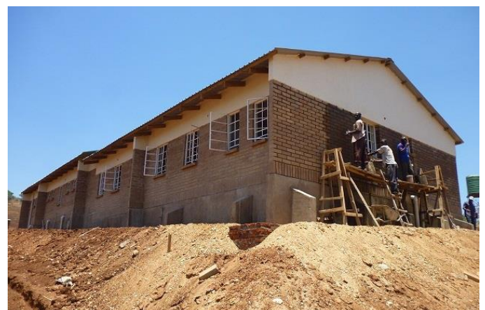
産科棟外観 屋根と窓枠・窓ガラスの取り付けを終え、外壁の塗装を仕上げています 2013 年 11 月
