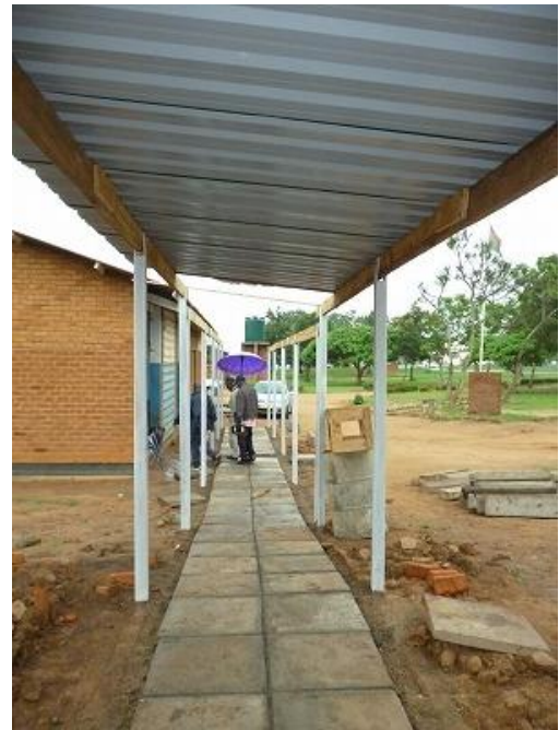
産科棟から既存の外来棟や HTC（HIV Testing Centre）につながる渡り廊下を現在設置中 2014 年 1 月
