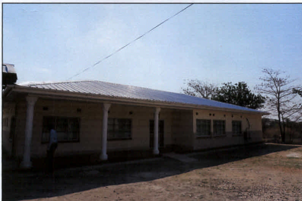
【写真①】 完成したムウェンベシ・クリニック ART センター（2014 年 9 月 17 日 ムウェンベシ）
