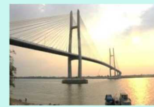
ネアックルン橋梁(つばさ橋)(カンボジア)
