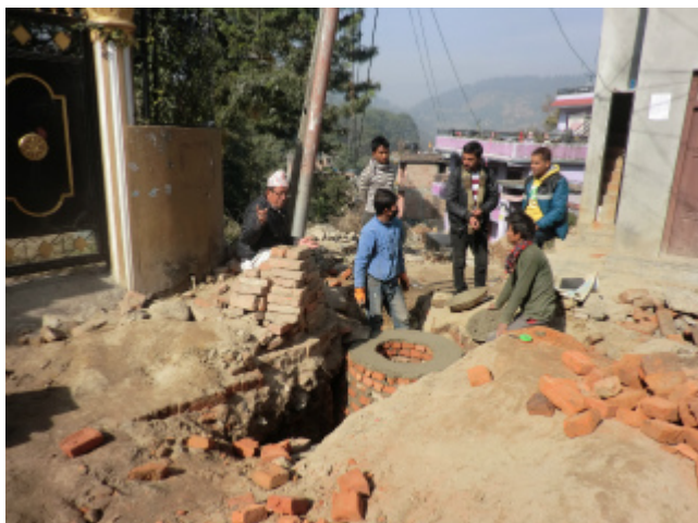
分散型排水処理施設（DEWATS）建設
