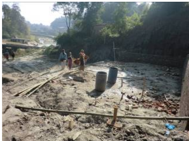
分散型排水処理施設（DEWATS）建設
