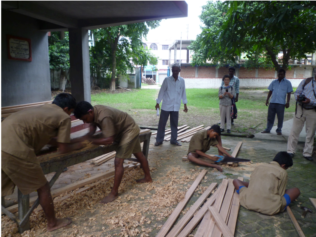
大工の訓練をする青年たち。家具を作るためにカンナの掛け方を練習する。
