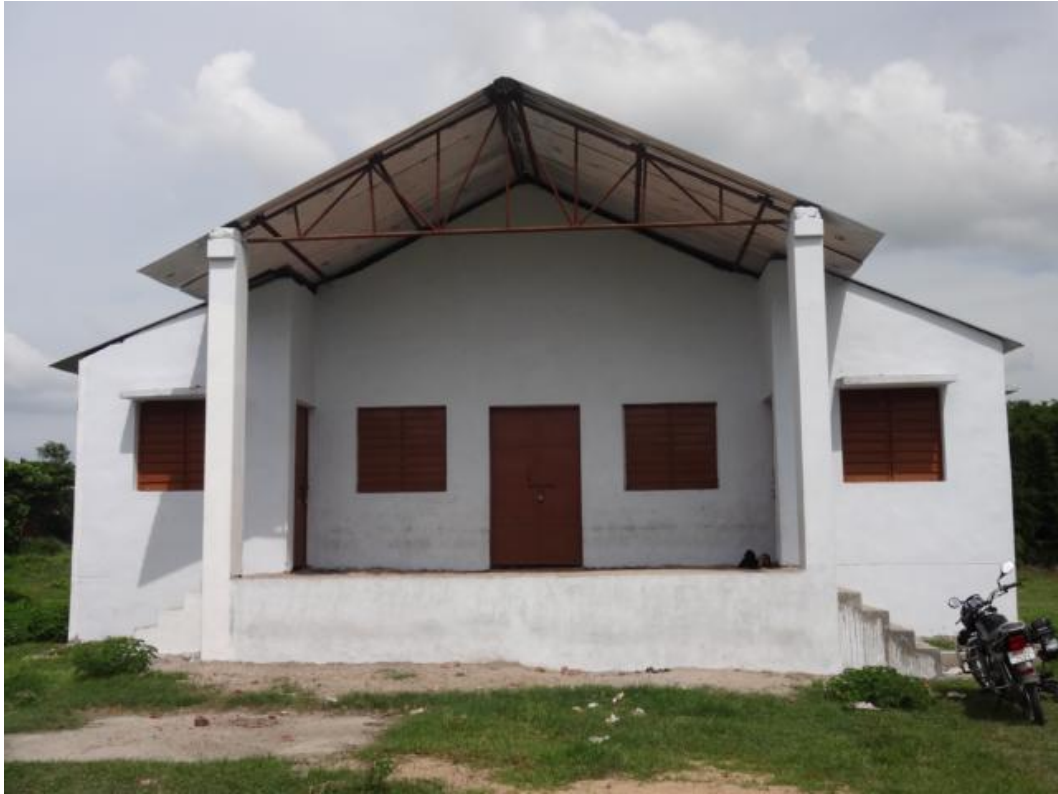
完成した Korlahi 村コミュニティセンター
