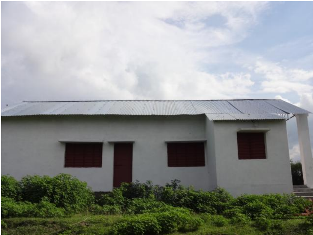
完成した Korlahi 村コミュニティーセンター
