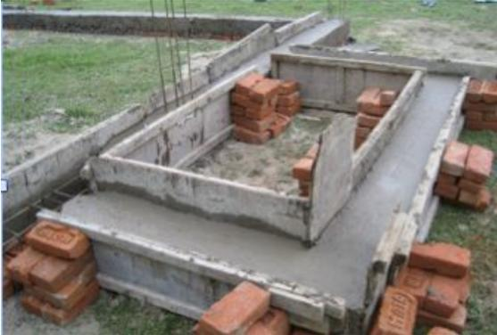
基礎型枠をつくりコンクリートを流し込む作業が進んでいる (07/09/2012)
