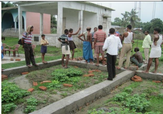
コミュニティセンターの土台のサイズが微妙に変化していたため、現地技術者を派遣して詳細に点検し、図面通りに修正してした。(07/09/2012)
