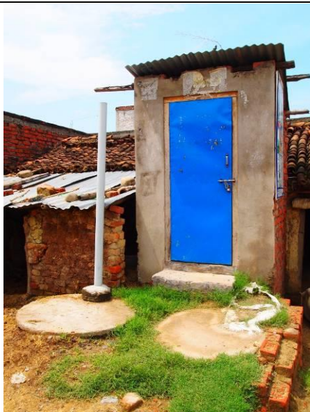
建設されたトイレ。2つの汚水槽が設置されており、いっぱいになると汲みとるシステム
