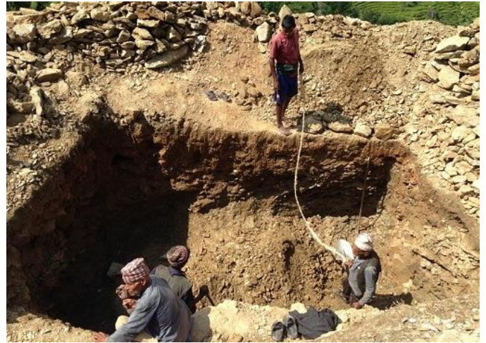
スワナウリ VDC 浄化槽となる場所の掘削作業の様子（2014 年 9 月撮影）
