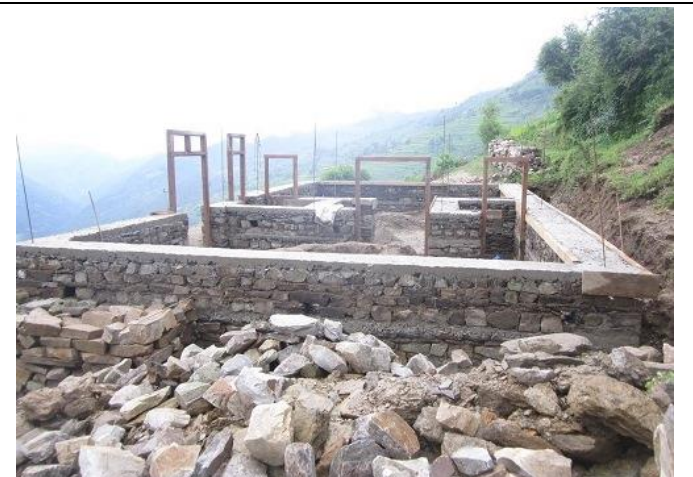
シャルマ VDC ドア枠の設置が完了。壁をさらに積み 上げていく作業が進んでいる（2014 年 9 月撮影）
