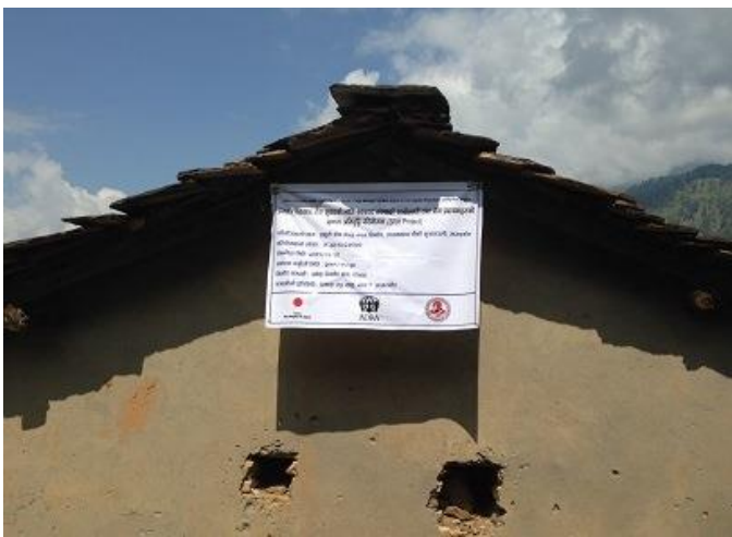
すべての建設地には施工業者名・施工期間・入札価格・ドナーロゴなどを記したバナーを掲示している。写真はスワナウリ VDC のもの（2014 年 9 月撮影）
