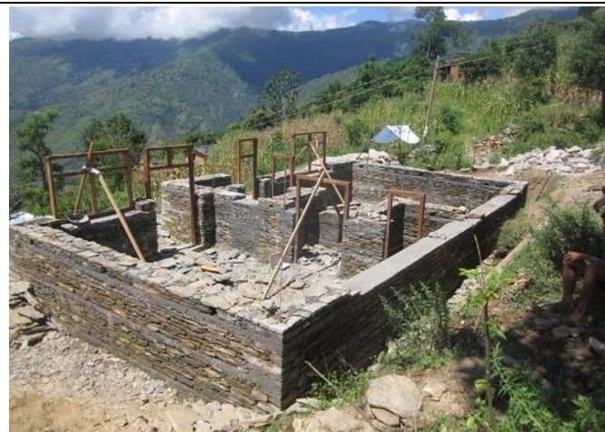
プンマ VDC 壁の積み上げ作業が進み、ドア枠と窓枠 の設置が完了した状態（2014 年 9 月撮影）
