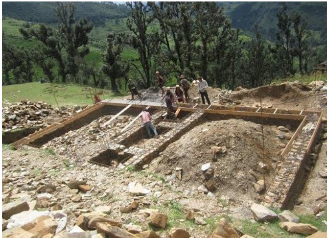
アルチャニ VDC 基礎工事が進んでいる （2014 年 9 月撮影）
