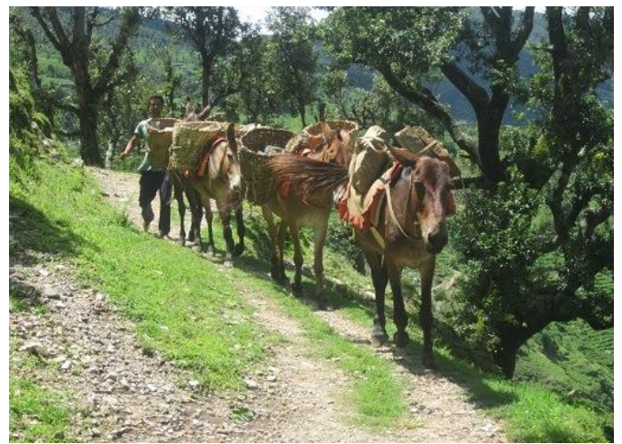
いずれの建設地も車道がないため、建設資材の運搬は人力もしくは動物に頼っている。写真はシャルマ VDC にて石を運んでいるラバ（2014 年 7 月撮影）
