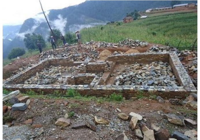
ディメ VDC 基礎が完成し、外壁となる岩を積み上げ ている（2014 年 9 月撮影）
