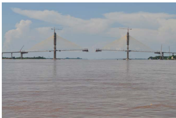
カンボジアのネアックルン橋 (現地調査時は建設中)
