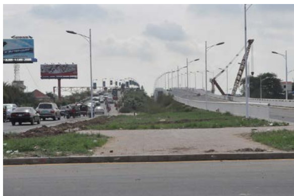
プノンペンの日本橋 (右側は中国が建設中の橋)
