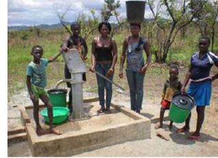
アンゴラの「ルアンダ近郊諸州緊急地方給水計画」において供与された機材で整備された深井戸と利用者。（写真提供：JICA）
