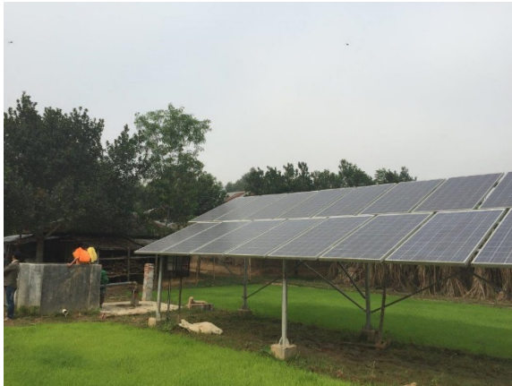
灌漑ポンプ用太陽光発電システム
