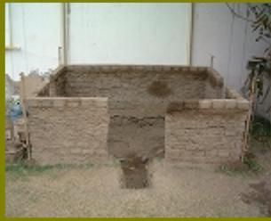
着工から1ヶ月。8段まで積み上がりました。床の部分の土を掘り、石を取りだしてから水を混ぜてこね、型につめてアドベを作る、、、そして一段ずつ組み立てています。総合的な学習の時間だけでなく、放課後や休み時間もつかってがんばっています。
