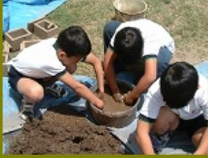
組み立てるためのモルタルをつくっています。モルタルとは、レンガとレンガをくっつけるセメントのような役割をするものです。アドベと同じ土をドロドロ状態になるまで水を加えて作ります。
