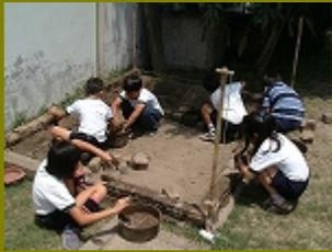
いよいよ組み立て開始。基礎の上に、モルタルをぬって、レンガを並べていきます。四つ角に立てた棒に糸をかけ、その糸に合わせるようにまっすぐ並べます。
