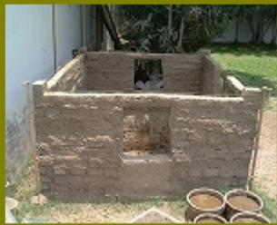
着工から40日。10段まで組み立てました。左右のかべに空けた窓は、10段目で閉じました。窓の上になる部分に木の板を渡してその上に板の厚さ分、うすく作ったアドベをのせました。当初からの目標は13段。いよいよカウントダウンです。
