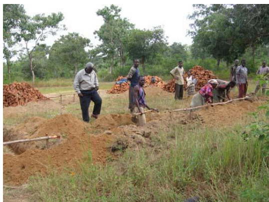
4月14日 ボランティアメンバー基礎工事
