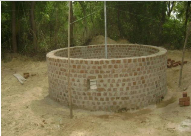
2012年7月 石作業が完了した井戸 (パッディパライ郡)
