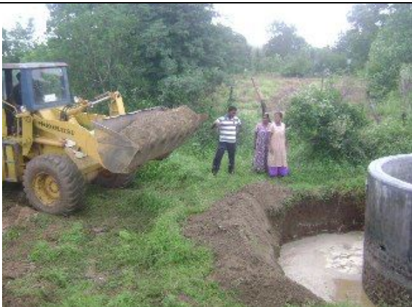
2012年12月 JCB型の小型掘削機による周囲の埋め立て (キラン郡)
