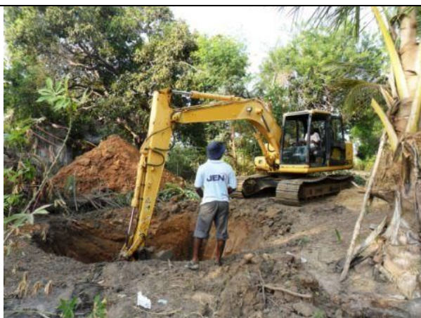
2012年5月 ウェラウエリ郡で井戸の掘削
