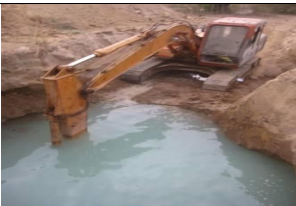
2012年6月 雨で崩壊した井戸の再掘削 (パッディパライ郡)
