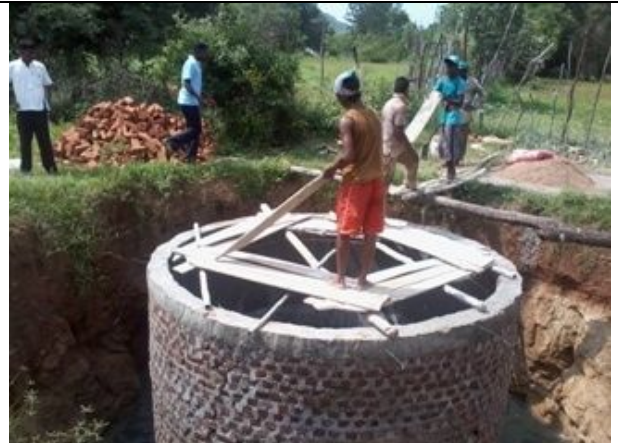
2012年11月 井戸上部の石作業用の足場組み (キラン郡)
