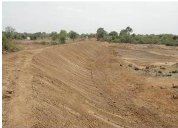
放水壁：新規放水壁設置のための掘削作業中（2012年7月30日）
