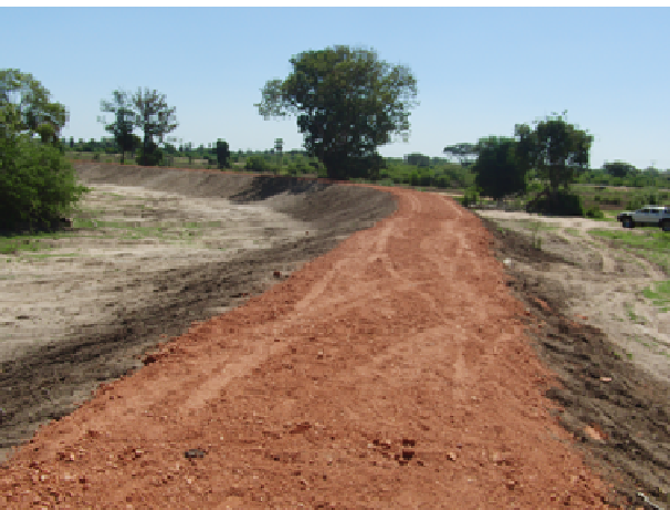
グラベル敷詰作業（2012年10月2日）
