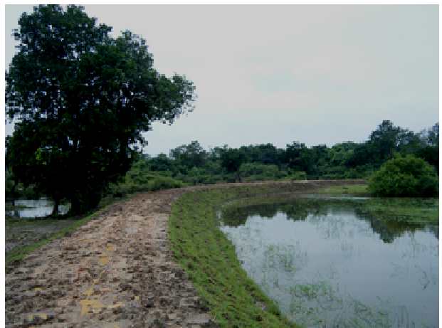
修復作業完了後（2012年1月4日）
