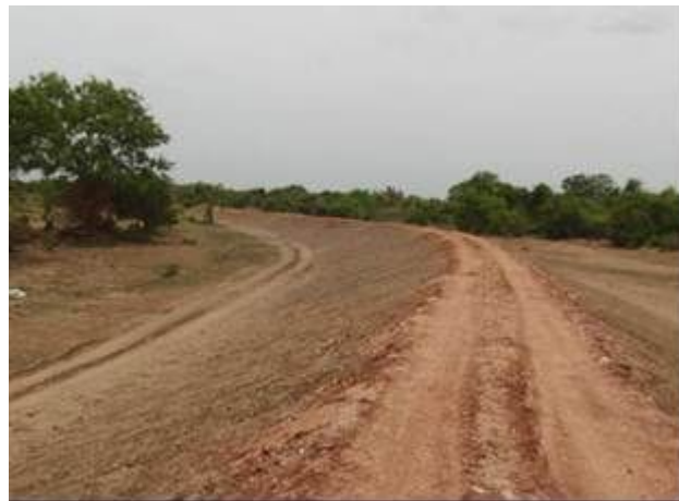
堤防：グラベル敷詰後（2012年8月3日）
