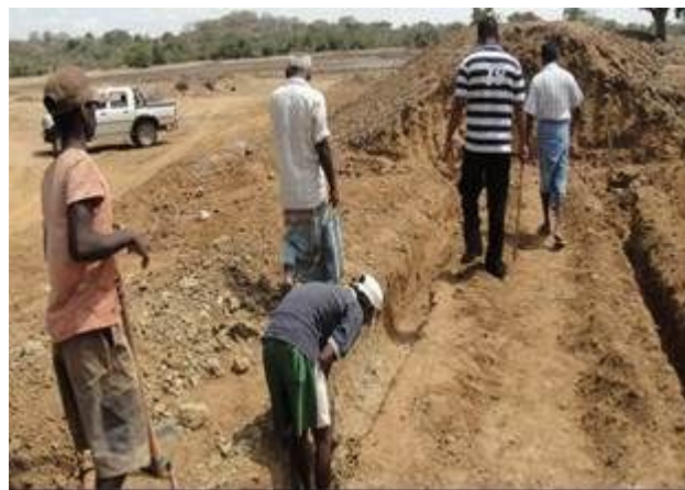
放水壁：掘削作業中（2012年8月10日）
