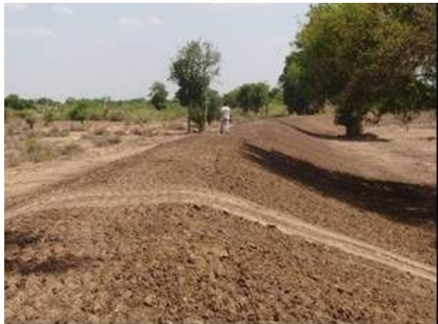
堤防：締固め作業完了箇所（2012年7月4日）
