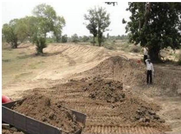
堤防：決壊箇所修復中（2012年5月25日）
