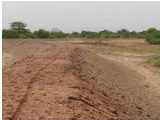
堤防：グラベル敷詰後（2012年7月17日）
