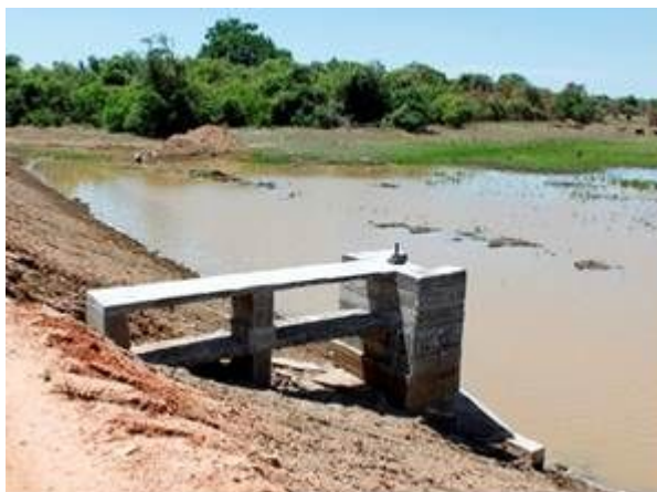
水門設置完了後（2012年10月5日）
