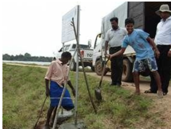
サインボード設置作業（2013年2月27日）
