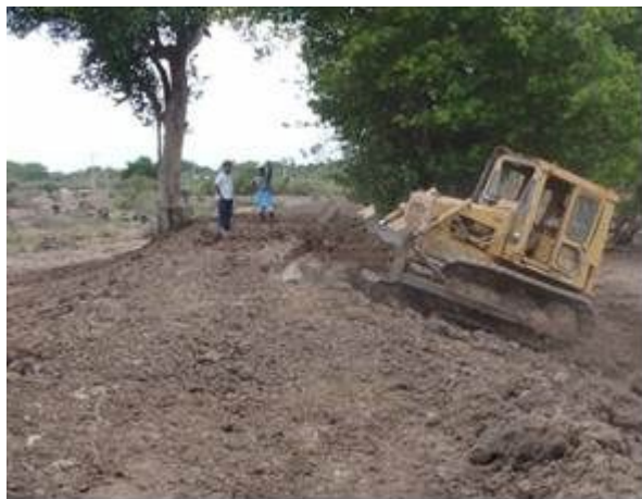
堤防：嵩上げ作業中（2012年6月22日）
