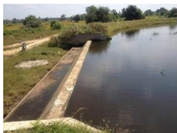
修復作業完了後（2012年1月31日）
