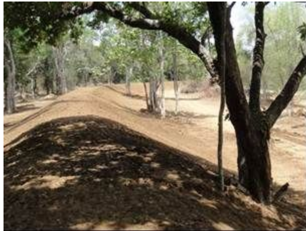
堤防：嵩上げ作業完了後（2012年6月29日）
