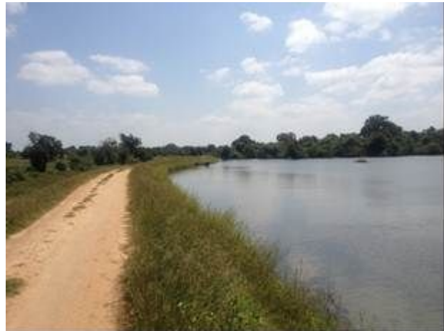
修復作業完了後（2012年1月31日）
