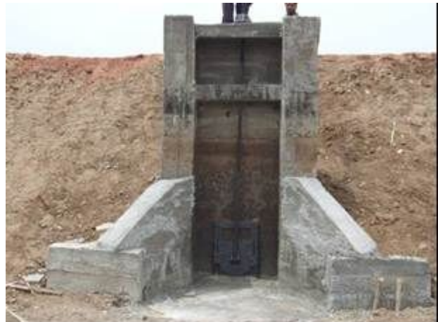
水門：ゲート交換（2012年8月3日）
