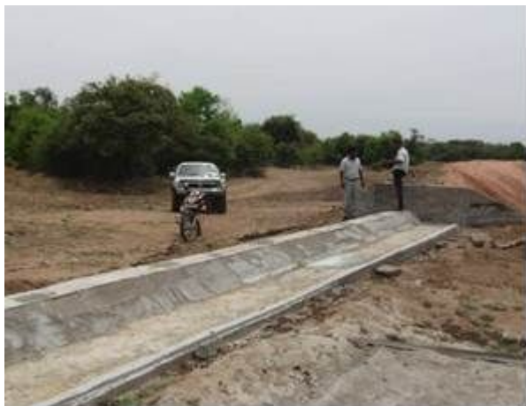
放水壁：設置完了後（2012年8月3日）
