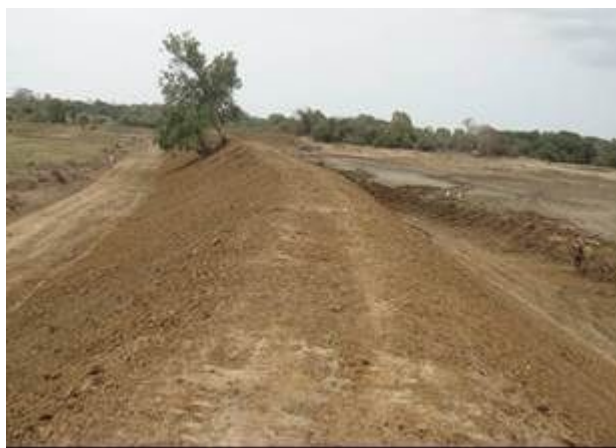
堤防：締固め作業完了後（2012年7月24日）
