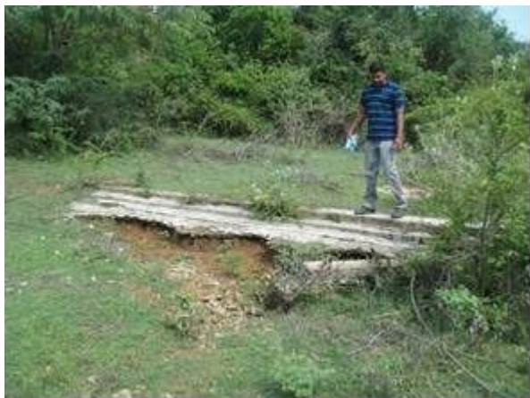
放水壁：除去前
