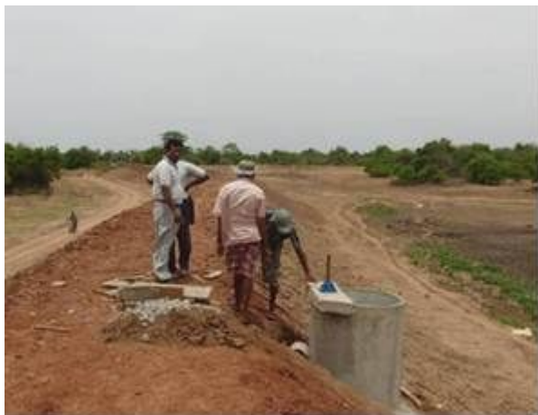
水門ゲート取替え作業（2012年8月3日）
