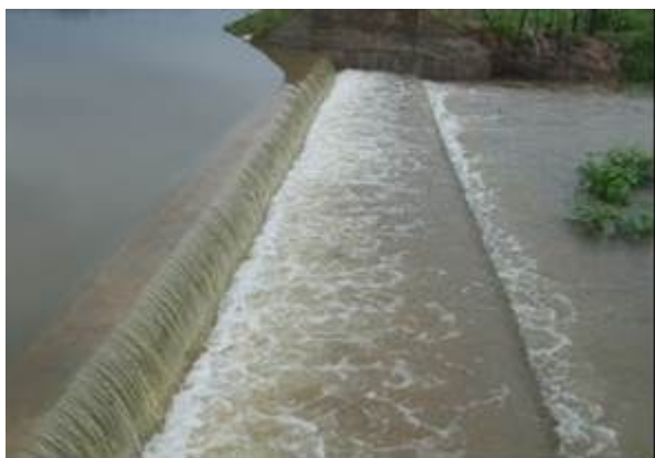
降雨後の放水壁。貯水池内の余剰の水が貯水池から流れている様子。（2012年12月3日）
