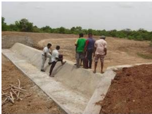
放水壁完成後（2012年8月3日）
