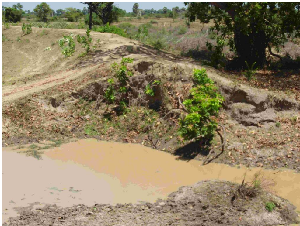
決壊した堤防 (クッチャベリー郡カトゥウクラム村カトゥウクラム貯水池)
