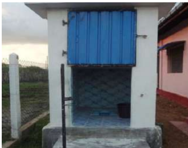
トイレの設置
