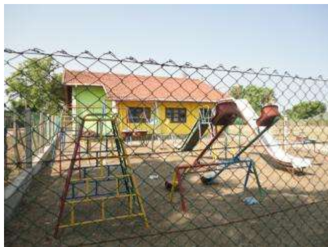
フェンスを新たに設置
