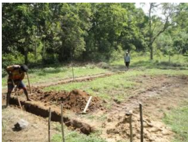
ECCD センターの建設 2012年5月 Samanpura 村
