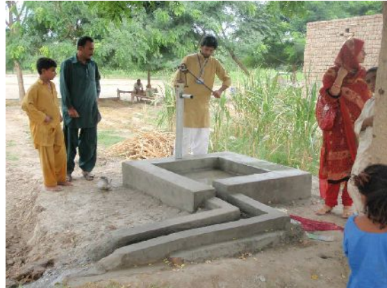
水質検査後に新設し完成した井戸。井戸は新設されたが事業地及び周辺地域は水中のヒ素濃度が高く水質改善が必要である。
