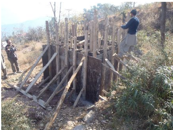
貯水タンク基礎工事
