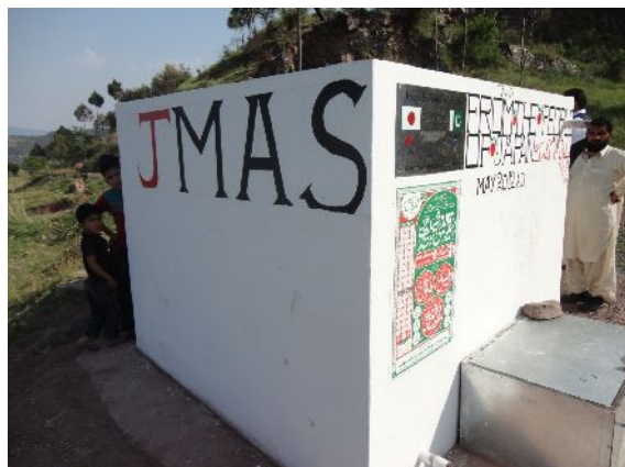
完成したサブタンク
