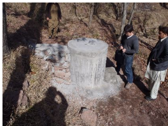
完成した水源タンク
