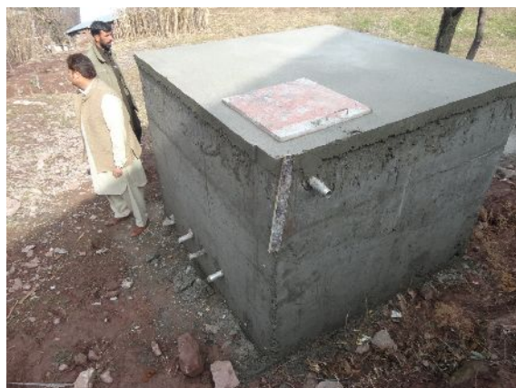
概成した貯水タンク
