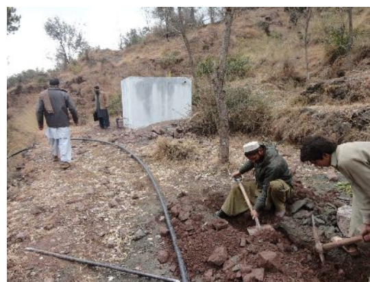
高低差を利用して、水源タンクからメインタンク、サブタンクへとパイプを敷設。
