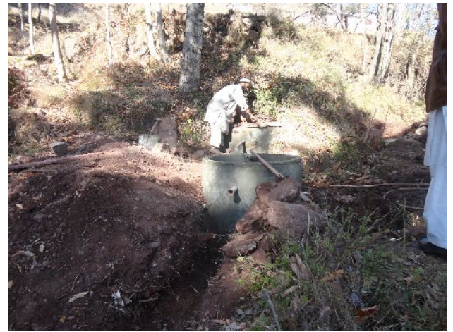
水源保護タンクの建設
