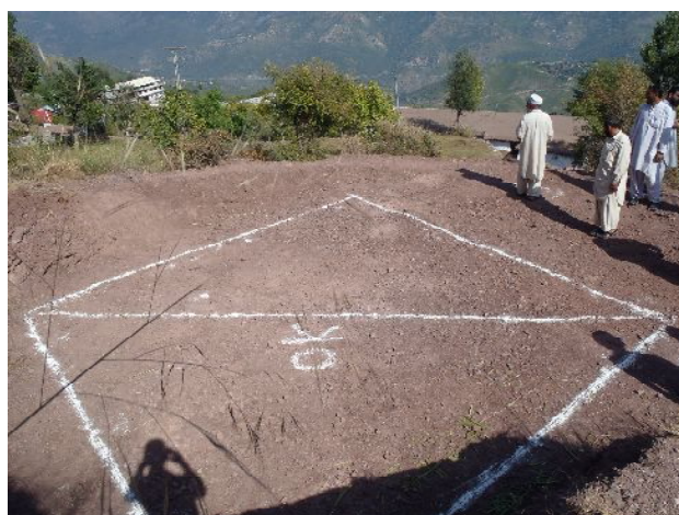
メインタンク建設予定地整地完了
