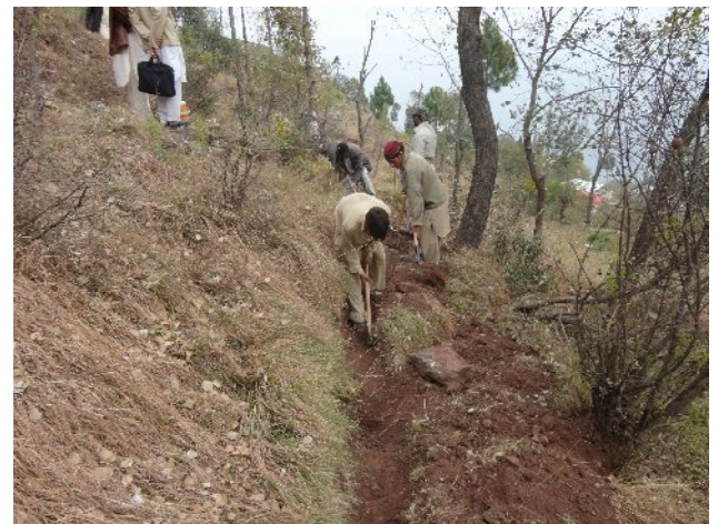
水源からメインタンク・サブタンクへの給水管敷設基礎工事
