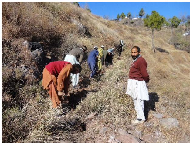
水源からメインタンク・サブタンクへの給水管敷設基礎工事
