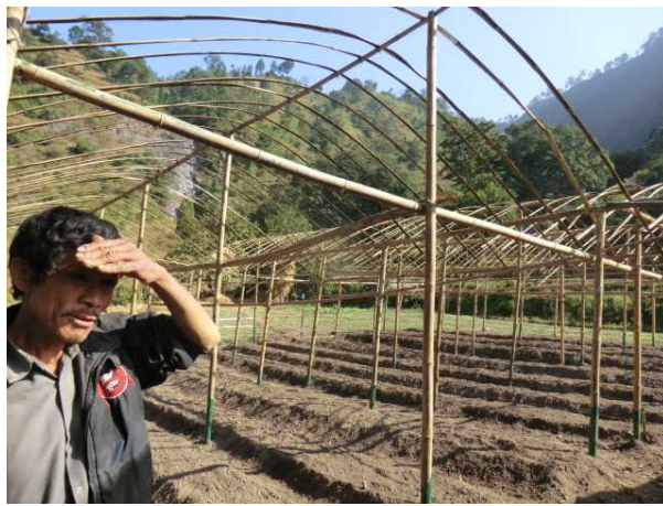
11月下旬、研修に備えて、自発的に3個のハウス建設を進める住民
