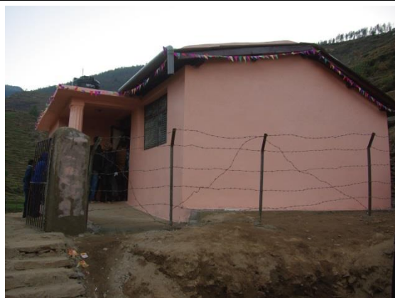
オダナク VDC のお産センター。野生動物により建物に被害が及ぶ可能性があるため、敷地を針金で囲み、コンクリ製の門柱も設置している（2014 年 3 月撮影）
