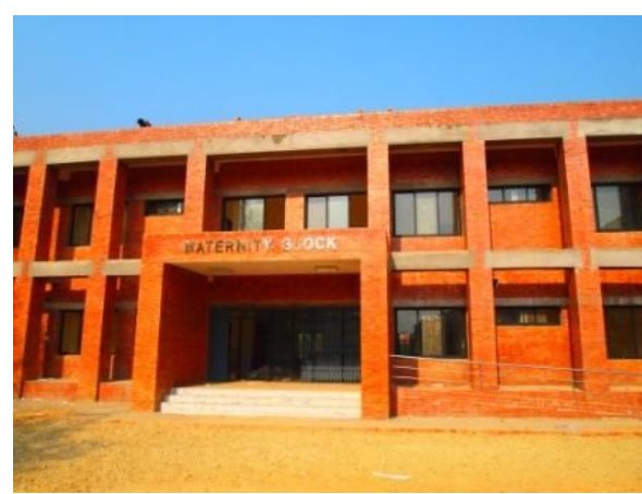
完成した周産期病棟
