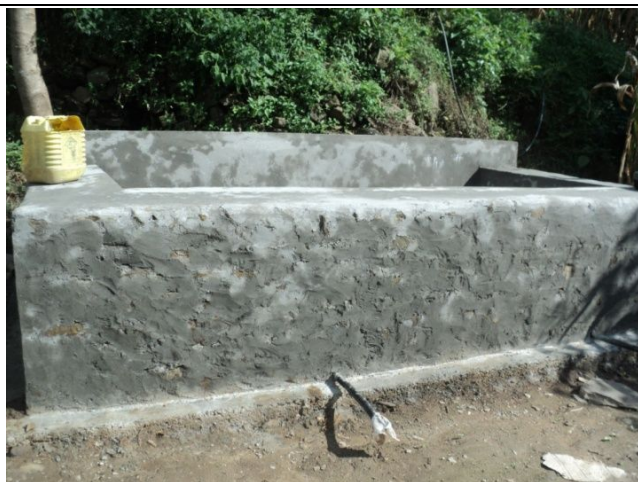
8 月、モデル農家によって設置されたミズ堆肥ピット。3 月の研修で準備されたミズ堆肥ピットで増えたミズを移植。
