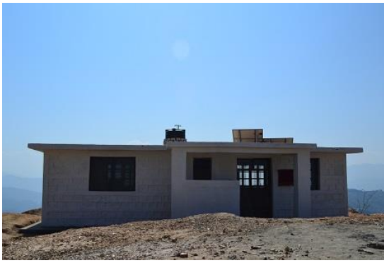
バイリカリカトゥム VDC お産センター 既存の簡易保健所と併設するため、小高い丘の上に建設された（2013 年 3 月撮影）
