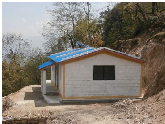
バワニ VDC お産センター 提供された土地の関係上、斜面に建設したため、トタン屋根にして建物の軽量化を図った （2013 年 3 月撮影）
