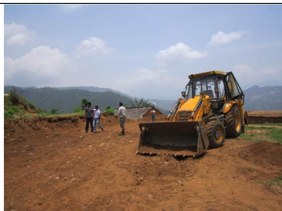
カリガイラ VDC の整地作業 (2012 年 7 月撮影)
