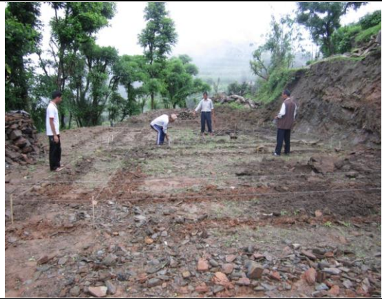
チャムンダ VDC の建設レイアウト作業。既存の SHP より下にある斜面を削って整地した後の写 真。(2012 年 7 月撮影)
