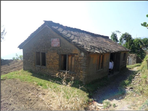
チャムンダ VDC にある、既存の SHP (2012 年 4 月撮影)
