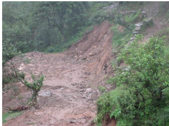
バワニ VDC のお産センター建設予定地。既存の SHP から徒歩 1 分の場所に位置する斜面を削って整地した後の写真。(2012 年 6 月撮影)
