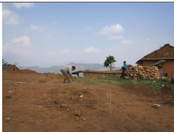
カリガイラ VDC の建設レイアウト作業 (2012 年 7 月撮影)
