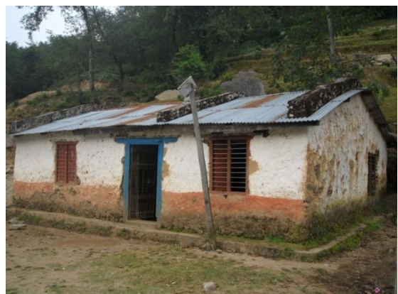
バワニ VDC にある、既存の簡易保健所 (SHP) (2012 年 4 月撮影)
