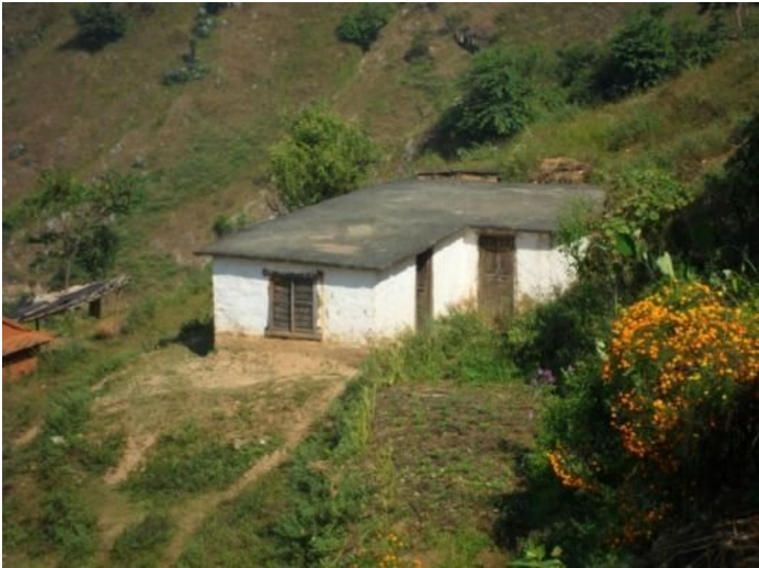
ダイレク郡カリガイラ村の簡易保健所。この簡易保健所にお産センターを建設する
