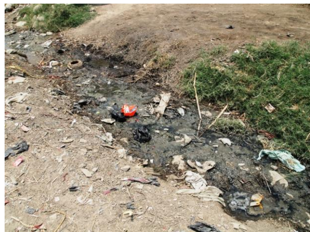
排水溝が未整備のため、ごみや泥が溜まり、常に異臭が 漂っている
