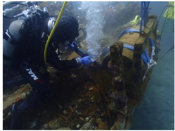
エアソーによる投射台からの爆雷切り離し作業
