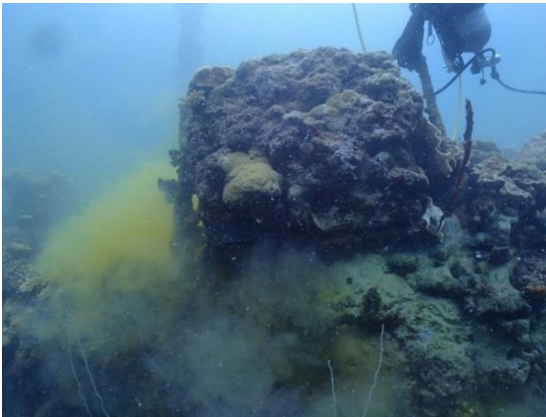
サンゴ等で覆われた投射台 (内部には爆破処理対象の信管付爆雷装填)
