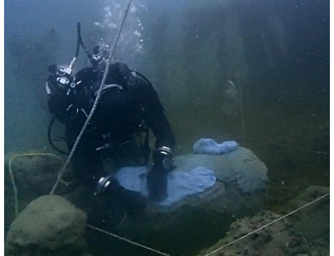
水中硬化型防食材による爆雷の亀裂補修処置
