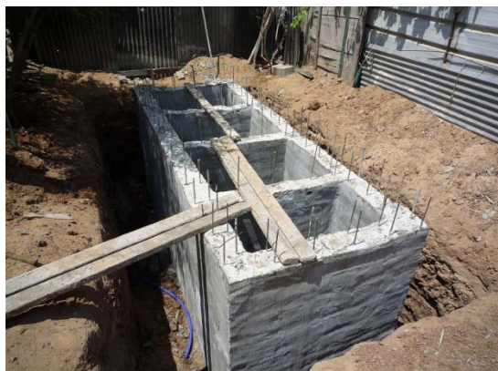
家庭雑排水処理施設組立作業
