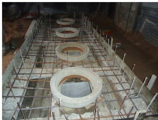
濾過チャンバー上面設置作業
