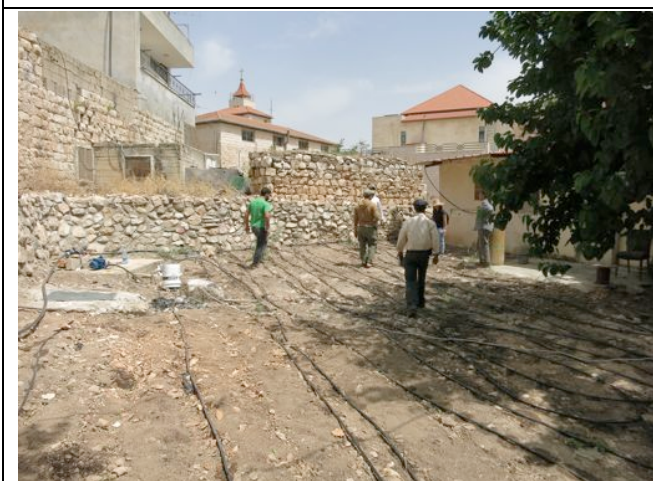
【15】灌漑設備の設置の様子。現地農業技師の監督の下、各菜園の周辺環境に合わせてデザインする。(2013年5月)
