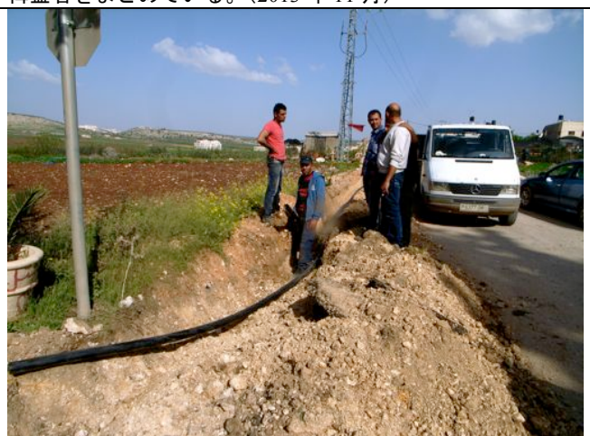
【10】井戸と農地をつなぐ配水パイプの設置工事の様子。設置完了後は、低コストで安定的に灌漑用水を確保することができる。(2013年12月)
