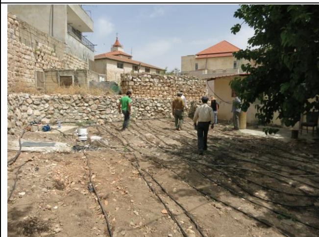
【写真11】灌漑設備の設置の様子。現地農業技師の監督の下、各菜園の周辺環境に合わせてデザインする。(2013年5月)
