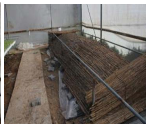
日本式接木養生設備の設置
