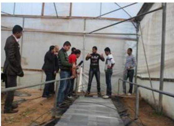
日本式接木養生設備の設置
