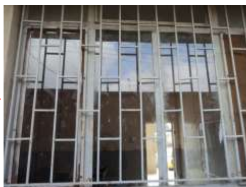
学校の改修工事。教室の窓を修復。破損は、生徒のいたずらも原因なので、修復と同時に、子どもたち自らが学習環境をケアすることが重要であることを、子ども会の活動を通じて訴えた。
