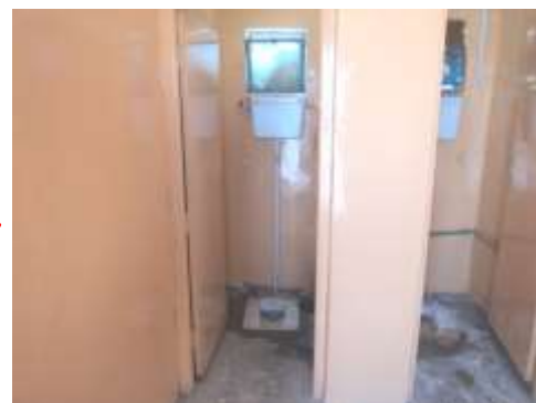
トイレ施設の改修。トイレは、子どもたちが最も改善が必要であると考えている場所。また、同時にユーザーである子どもたち自身がきれいにトイレを使うよう呼びかけた。
